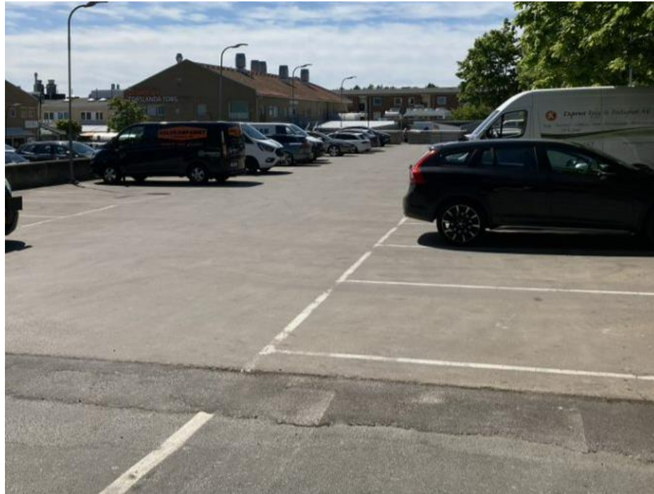
Figur 6. Tak på parkeringsgarage i fastighetens nordöstra hörn (COWI AB, 2023).
